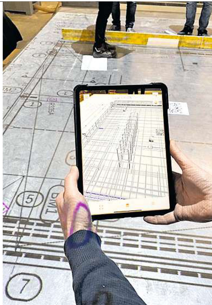
Maßstabgetreue Projektion des Bauplanes auf die Arbeitsfläche
