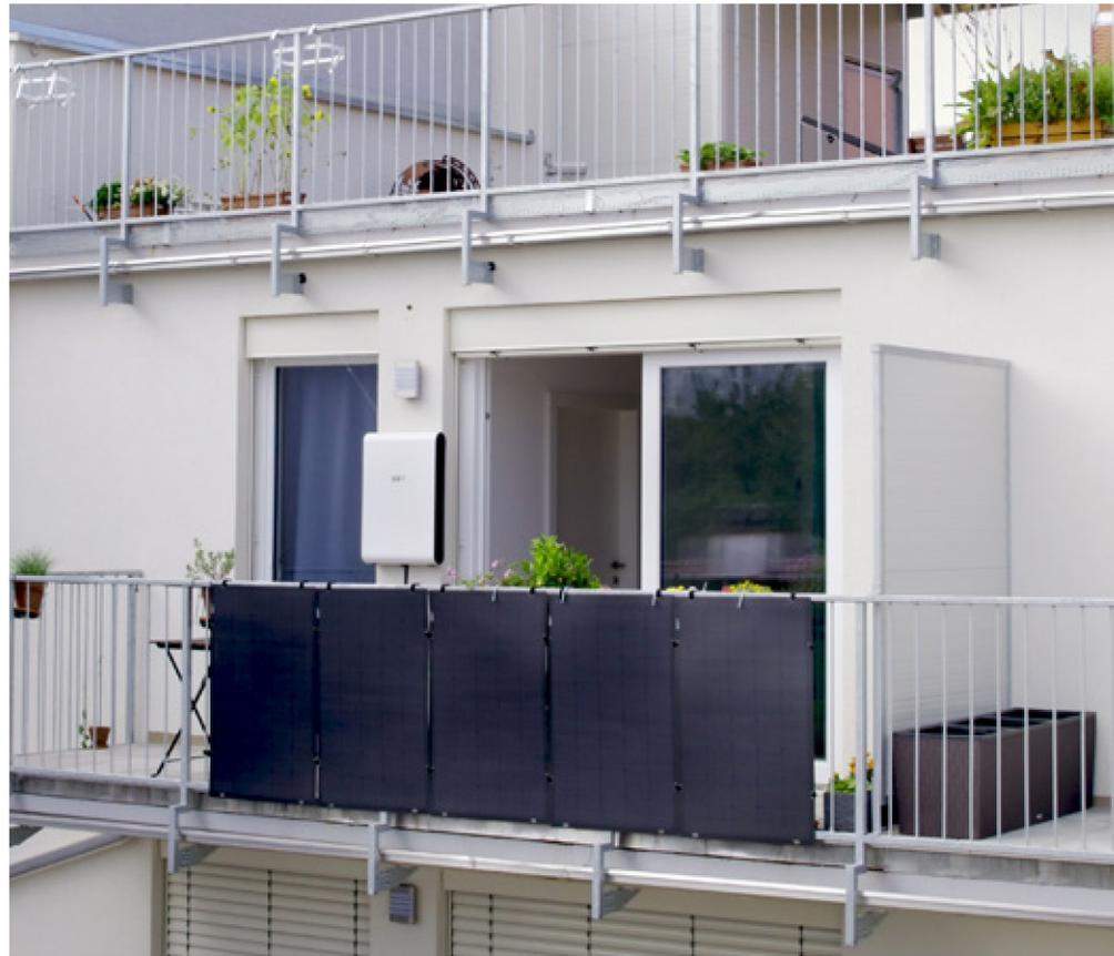
**Plug and Play:** PV-System zu entwickeln, bei dem die Messtechnologie direkt im Speicher verbaut ist
